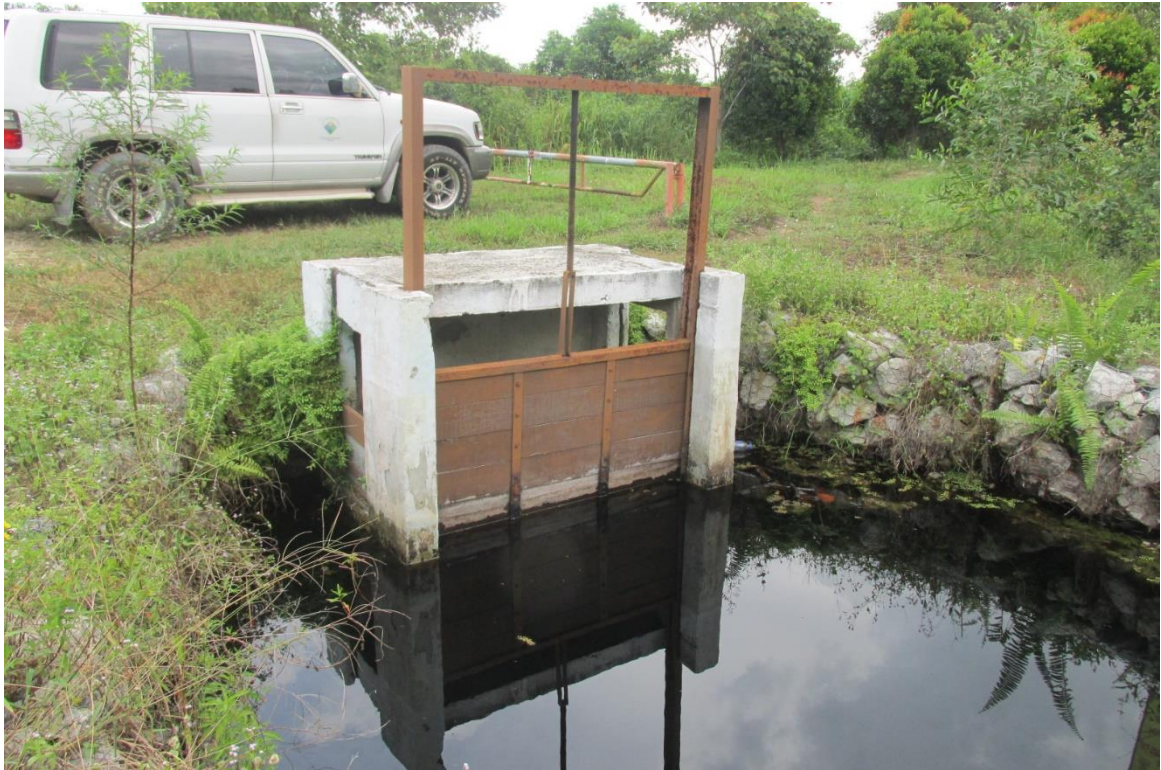
Foto 4.6: Pembinaan check dam di Hutan Simpan Kuala Langat Utara (Pulau Kempas), Mukim Tanjung 12, Kuala Langat.
