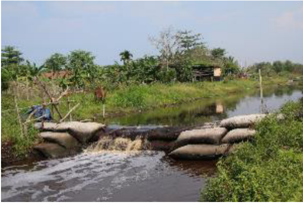
Sekatan Saliran di Penur, Pahang Check Dam in Penur, Pahang
