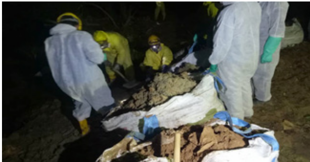
Kerja-Kerja Pembersihan dan Pengumpulan Tanah Tercemar sedang Dilakukan Cleaning of the Scheduled Waste/ Contaminated Land in Progress
